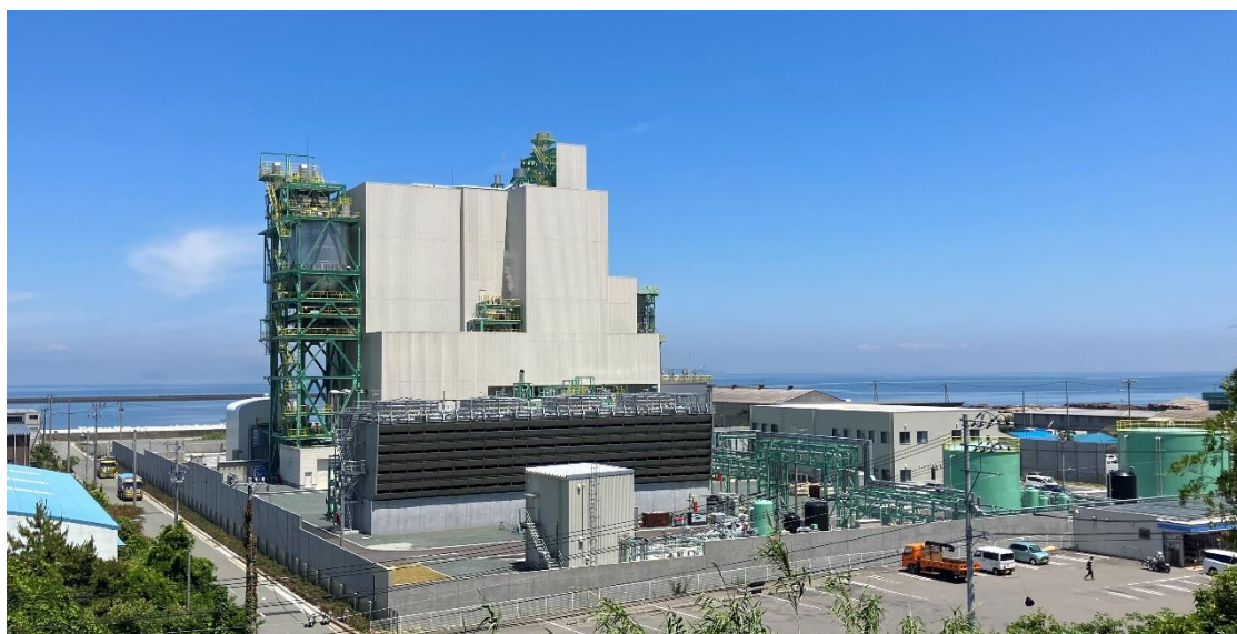
（大洲バイオマス発電所 全景）
